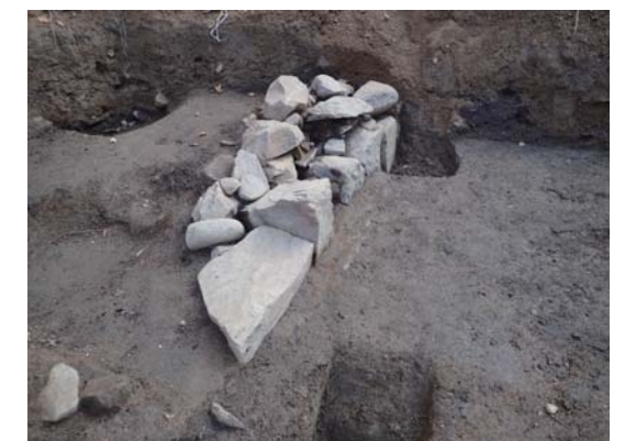
写真6 土塀基礎（北西より）
